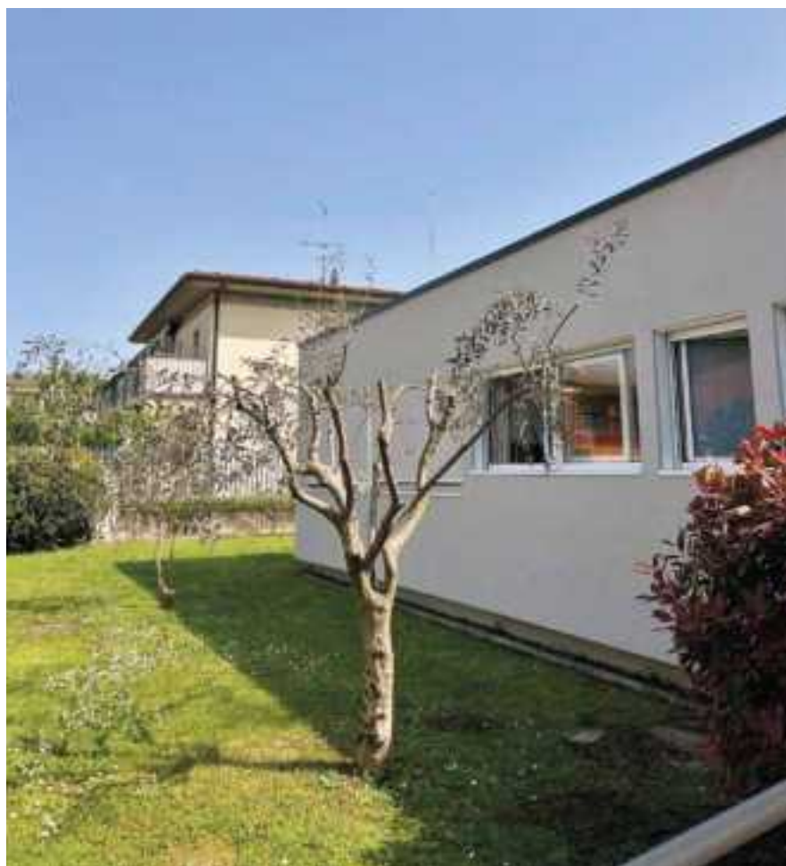
Lavori di efficientamento energetico al CDD di Rudiano
